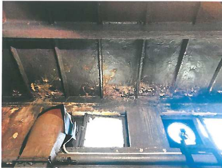
Rys. 5.11 Ślady po zamakaniu na spodzie żebrowych płyt dachowych, uszkodzona powłoka malarska.
