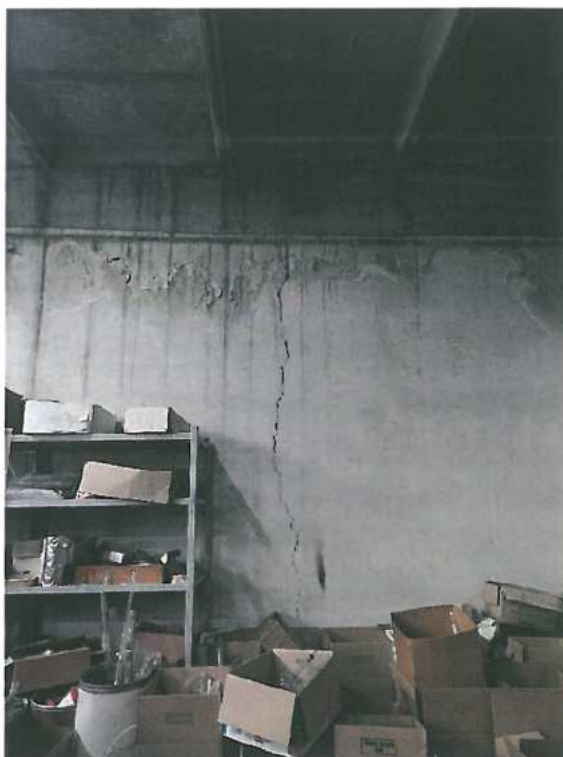
Rys. 5.13 Pionowe pęknięcie ściany wypełniającej.
