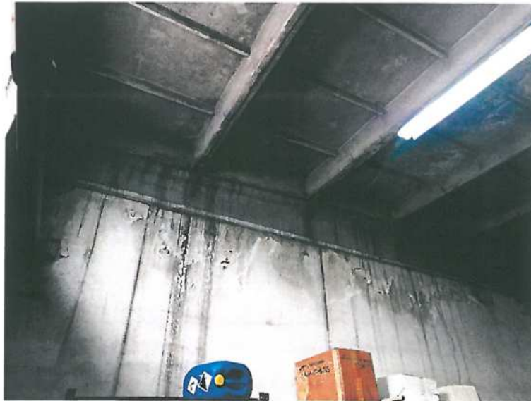
Rys. 5.8 Widoczne ślady przecieków na ścianie wewnętrznej.
