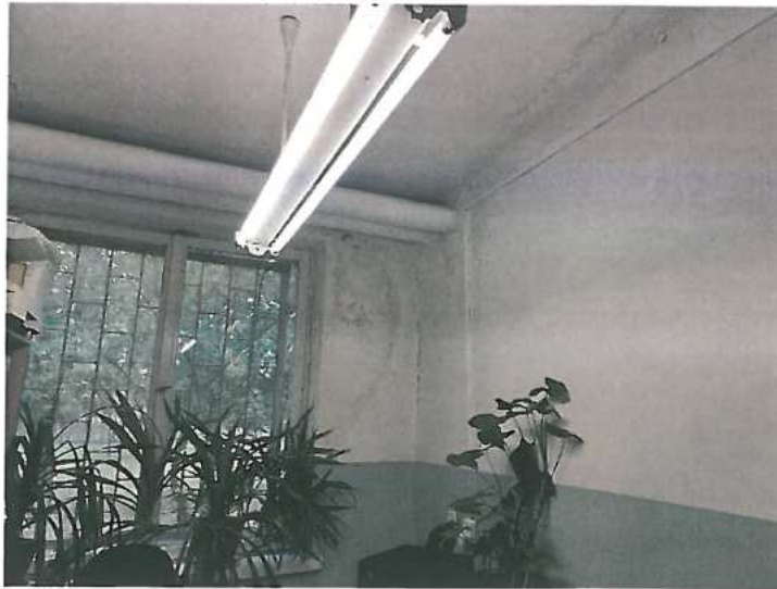
Rys. 5.21 Pęknięcie w narożu oraz ślady zamakania.
