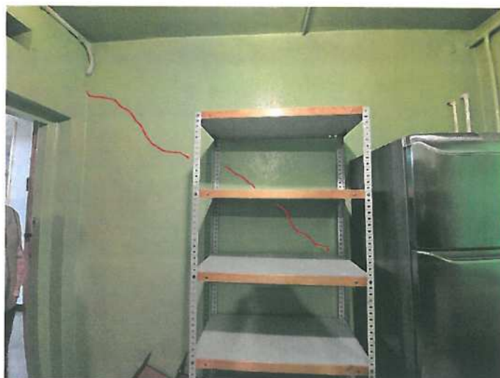
Rys. 5.23 Zarysowanie ściany.
