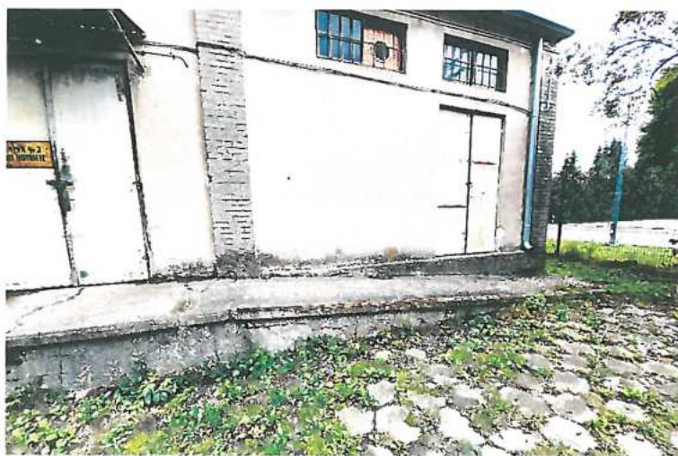
Rys. 5.7 Pęknięcie na cokole i pochylni żelbetowej.
