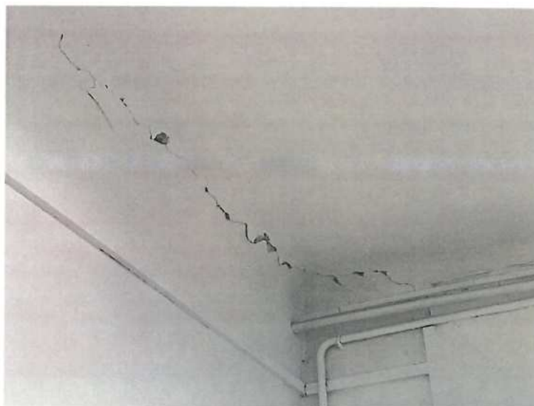
Rys. 5.20 Pęknięcie tynku na stropie.
