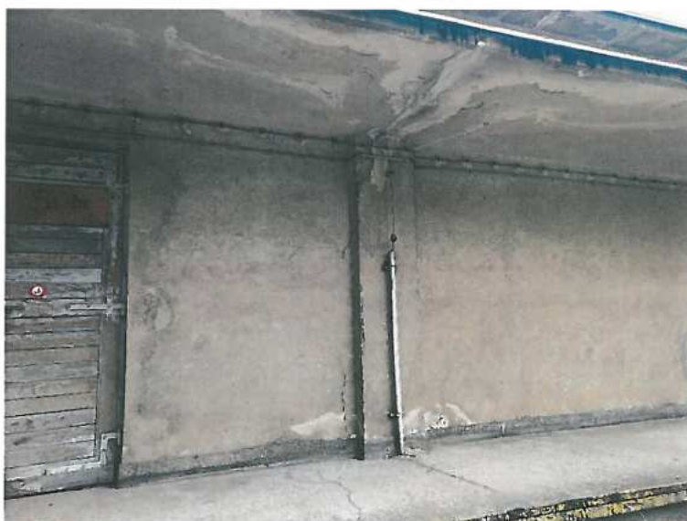
Rys. 5.1 Widoczne pęknięcie dylatacji.
