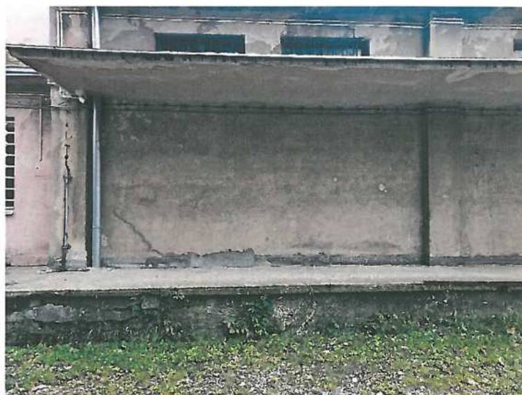
Rys. 5.4 Spękany tynk na ścianie zewnętrznej.
