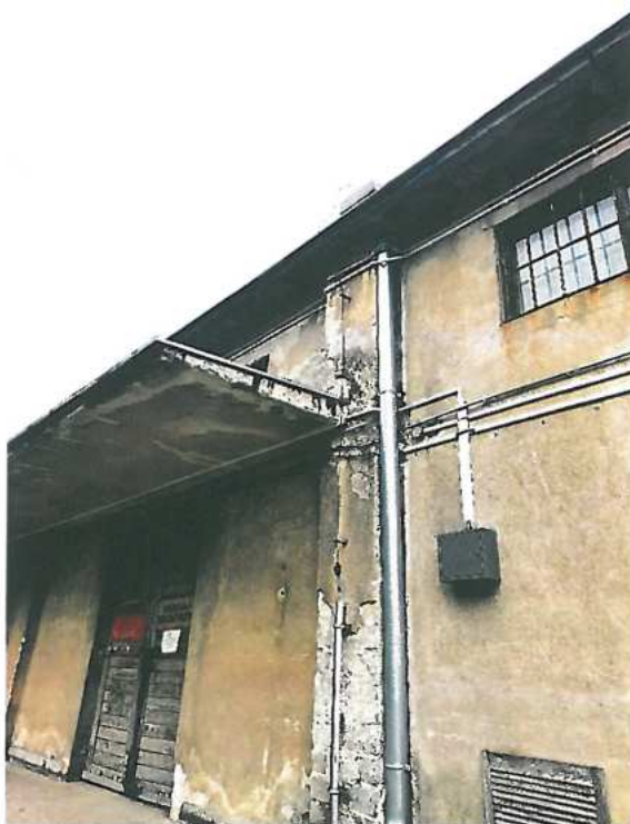
Rys. 5.6 Zdegradowany tynk na ścianie zewnętrznej.
