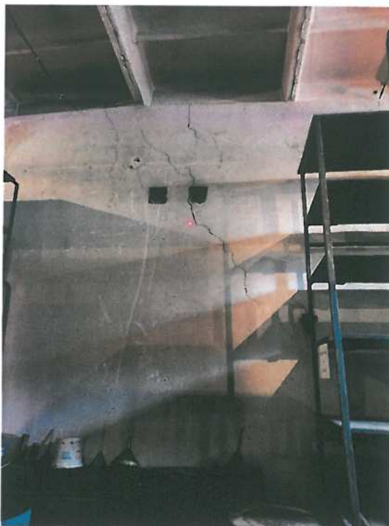
Rys. 5.17 Ukośne pęknięcie ściany zewnętrznej.
