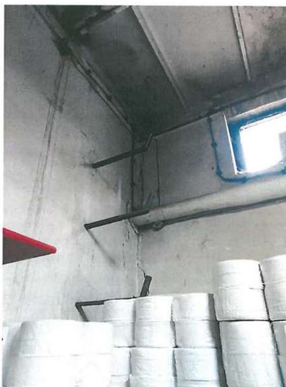
Rys. 5.18 Pęknięcie ściany w narożu.
