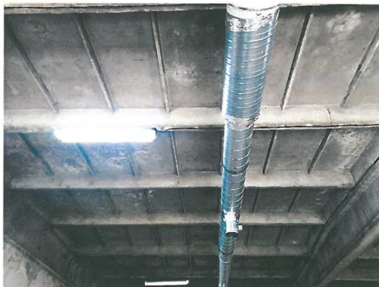
Rys. 5.9 Ślady zamakania i uszkodzenia otuliny na żebrowych płytach dachowych.
