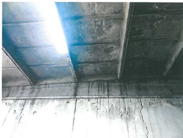
Rys. 5.10 Ślady zamakania i wykwyty solne na żebrowych płytach dachowych.
