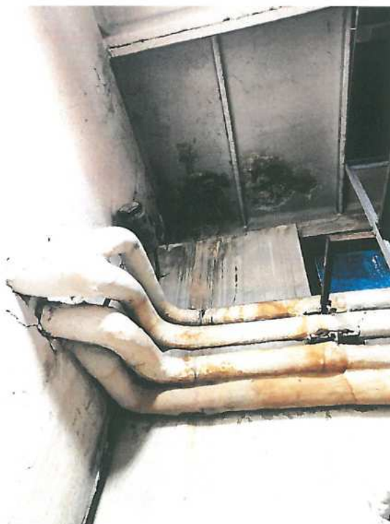
Rys. 5.12 Uszkodzenie płyt i ściany w wyniku wielokrotnego zalewania.
