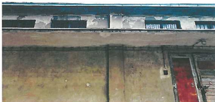
Rys. 5.5 Spękany i odspojony tynk na ścianie zewnętrznej.
