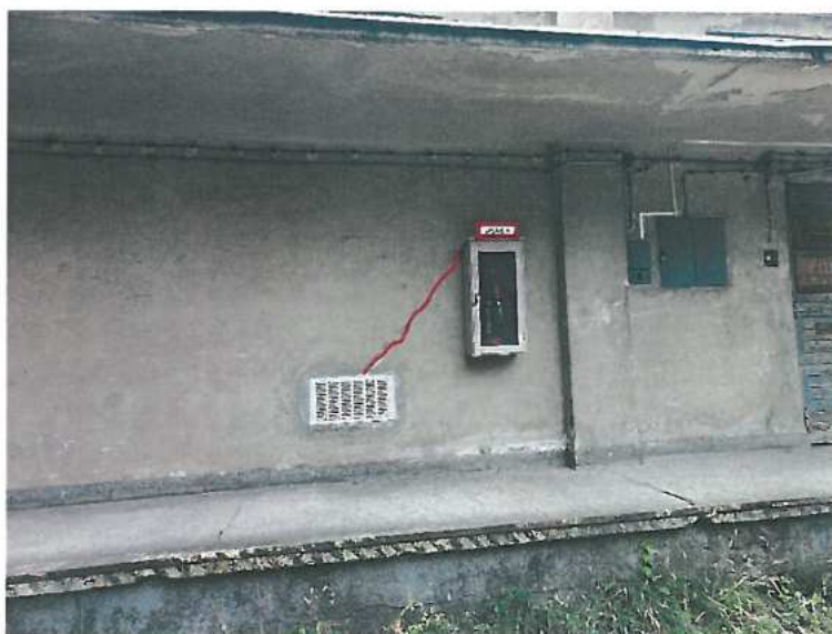
Rys. 5.2 Ukośne zarysowanie ściany zewnętrznej.
