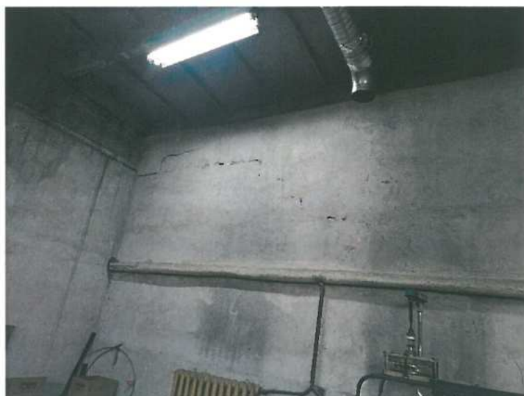
Rys. 5.14 Ukośne pęknięcie ściany zewnętrznej.
