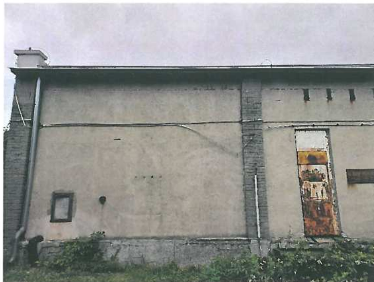
Rys. 5.3 Poziome zarysowanie pod okapem.
