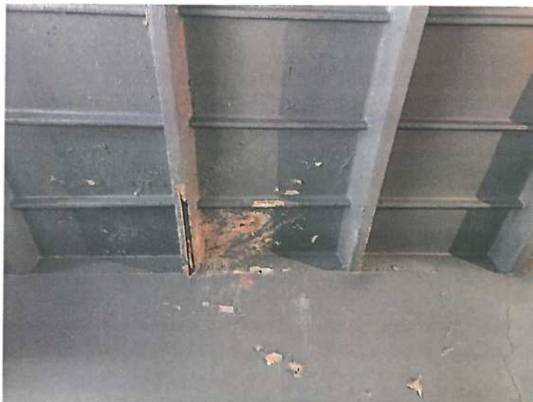
Rys. 5.19 Uszkodzone żeberko płyty stropodachu – brak otuliny.
