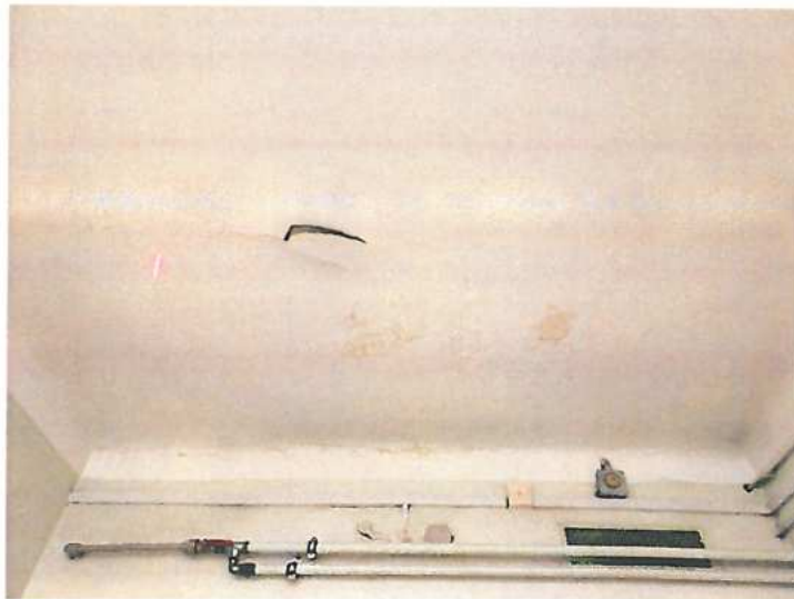
Rys. 5.22 Uszkodzenie farby, ślady zamakania.
