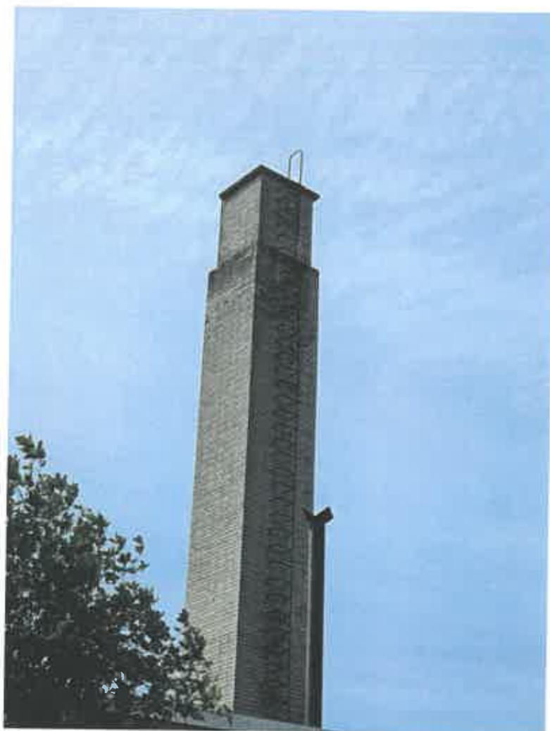
Ryc. 4. Komin od strony północnej i wschodniej.
