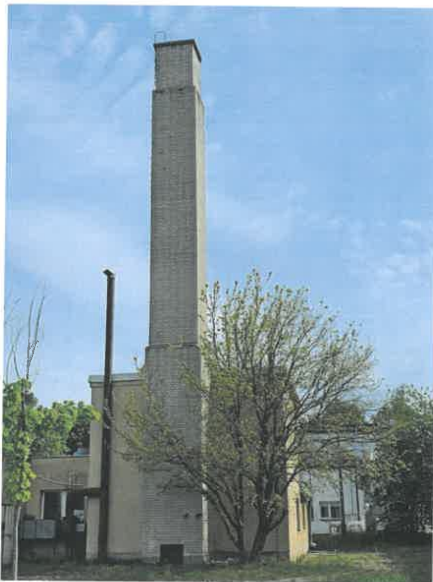
Ryc. 1. Komin od strony zachodniej.
