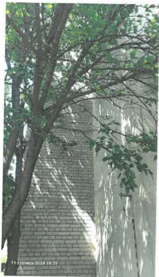
Rys. 4.2 Widok przylegającej ściany komina do ściany budynku.
