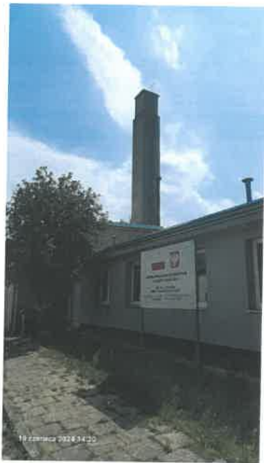
Rys. 3.5 Widok elewacji południowo-zachodniej.
