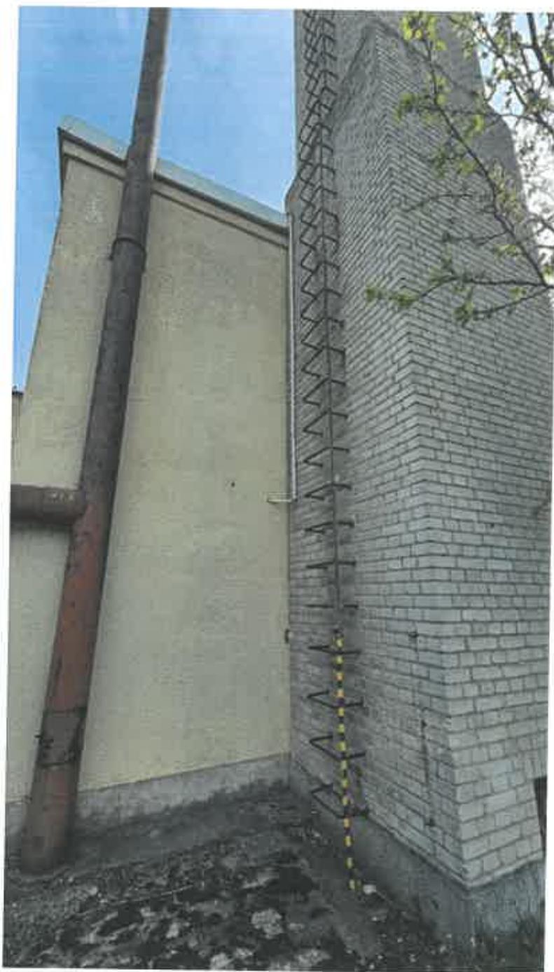
Ryc. 2. Komin od strony północnej i zachodniej.
