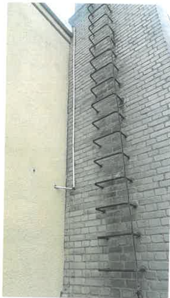
Rys. 4.3 Widok przylegającej ściany komina do ściany budynku.
