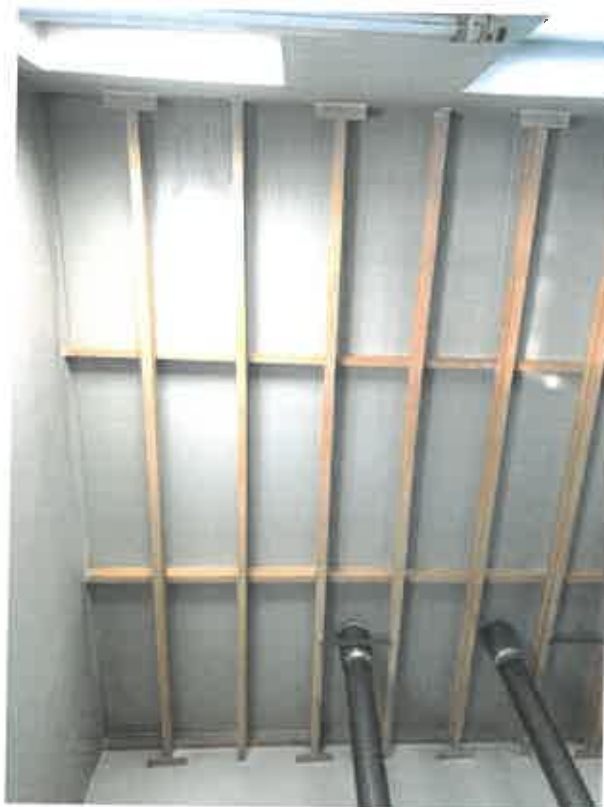
Rys. 4.1 Widok stropu stalowego w kotłowni.
