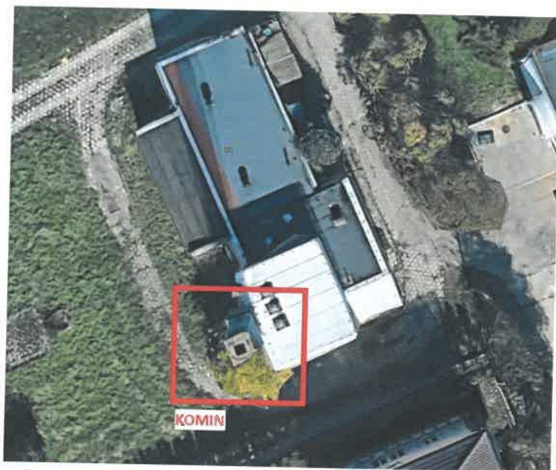
Rys. 3.3 Lokalizacja komina względem budynku 19 (źródło Google Maps).
