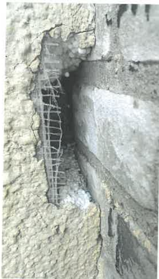
Rys. 4.4 Widok odkrywki w elemencie przy ścianie komina.
