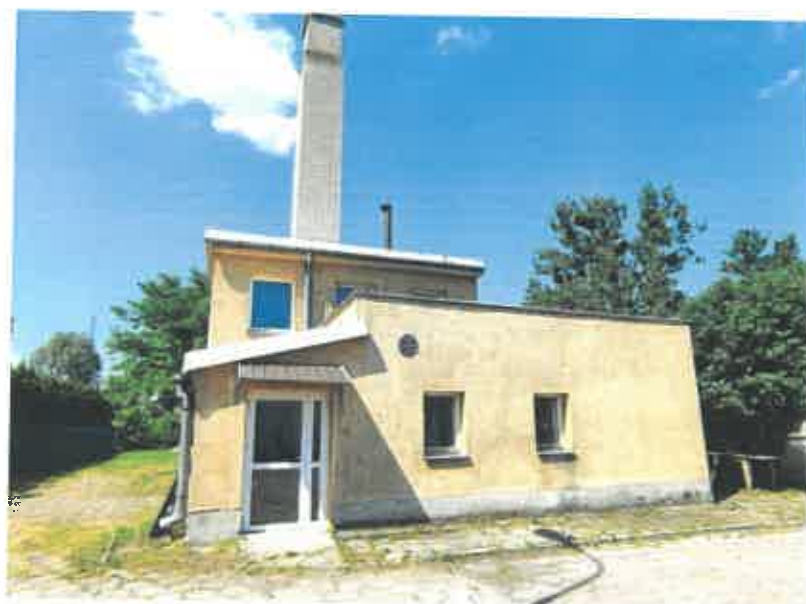
Rys. 3.6 Widok elewacji zachodniej.
